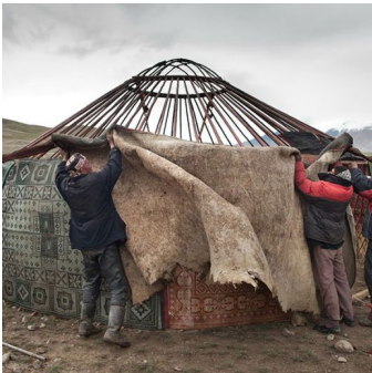
A yurt under construction (Paley n. d.).
