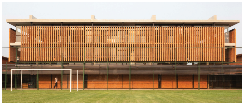
Brise-soleil. Equipo de Arquitectura, ASA Steam School, Asunción, Paraguay, 2020 (Equipo de Arquitectura 2020).
