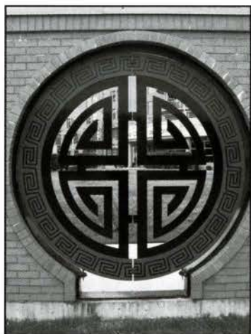
Ill. 33. Porte du jardin de l'hôpital chinois de Montréal, 189, avenue Viger. (Photo : Jonathan Cha)
