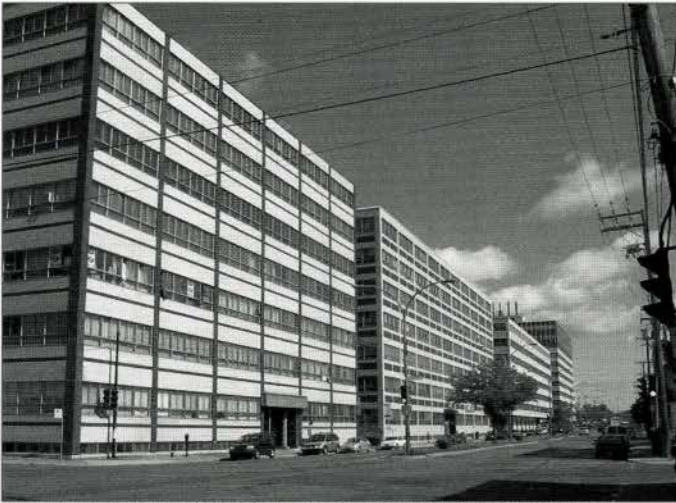
ILL. 2. ÉTAT DES LIEUX : RUE CHABANEL À L'ANGLE DE L'AVENUE DE L'ESPLANADE, MONTRÉAL. | MARK CALCE
