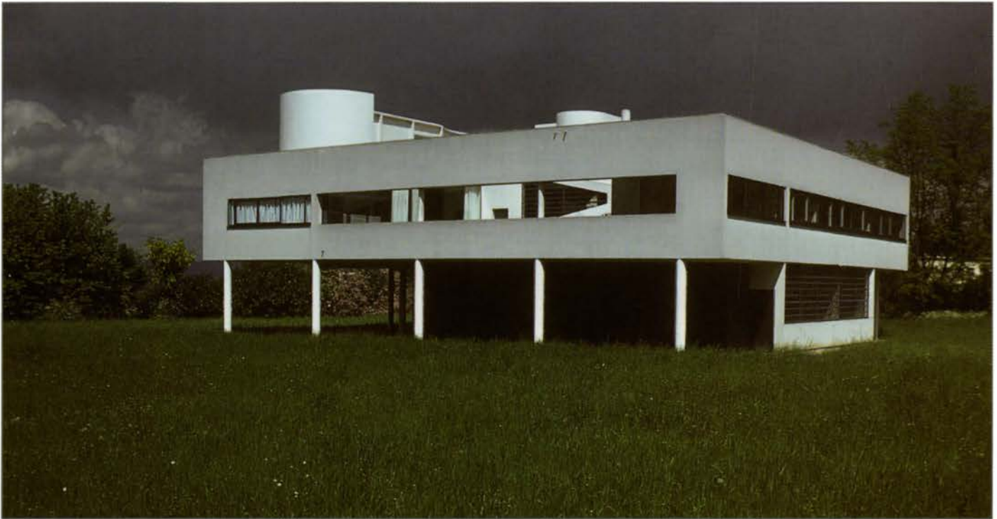
FIG. 11. VILLA SAVOYE, LE CORBUSIER, RESTORED. | PIERRE DU PREY 1987.
