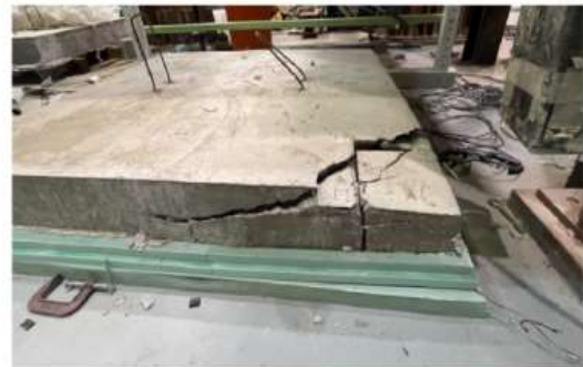
(d) failure in RB-300-CORNER
