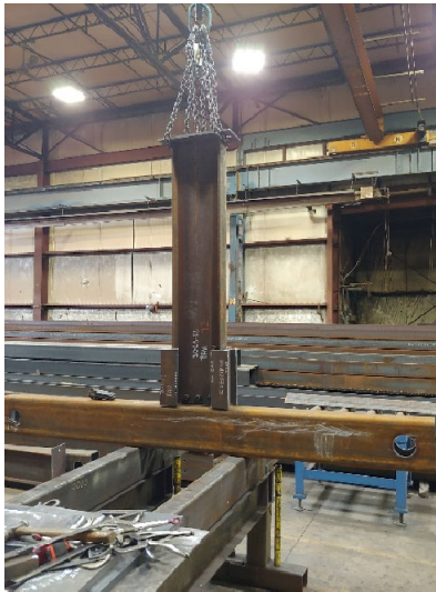
(b) beam fitup
