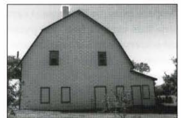
III. 8. Grange-étable revêtue de tuile d'amiante-ciment. Propriété M r Lemay à Québec. (photo Martin Dubois)
