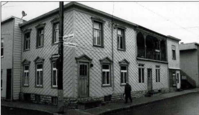
III. 7. Maison du quartier Saint-Sauveur à Québec. (photo Martin Dubois)
