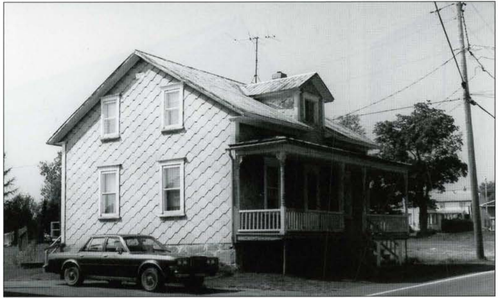
Ill. 11. Maison de Dosquet (Lotbinière) dont le revêtement d'amiante-ciment n'est pas peint. (photo Martin Dubois)
