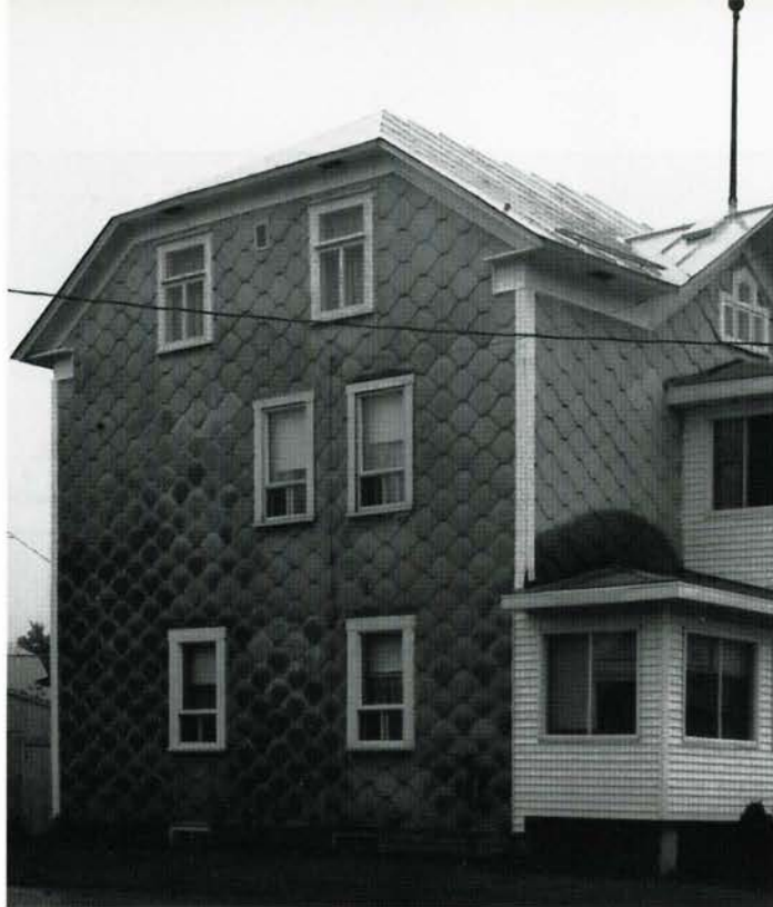
Ill. 1. Maison revêtue de tuile d'amiante-ciment à Robertsonville dans la région de l'Amiante. (photo Martin Dubois)
