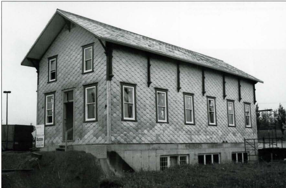
Ill. 16. Ancienne gare et temple méthodiste de Thetford Mines récemment restauré avec de nouvelles tuiles d'amiante-ciment. (photo Martin Dubois)
