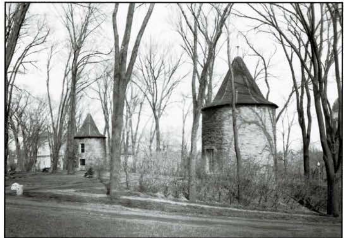
III. 13. « Fort des Messieurs de Saint-Sulpice, deux tours vues ensemble ». Vachon de Belmont, architecte, 1694. (Archives nationales du Québec, Inventaire des œuvres d'art, Fonds Gérard Morisset, B-6)
