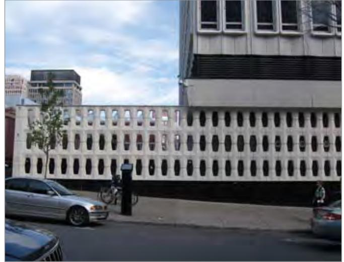
FIG. 11. SCREEN WALL ON THE BACK SIDE OF THE HALL BUILDING. | ANJA BORCK.
