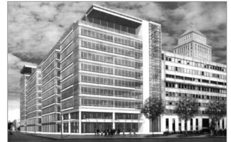
FIG. 19. CAISSE DE DÉPÔT ET PLACEMENT DU QUÉBEC, DAOUST LESTAGE ARCHITECTURE AND URBAN DESIGN, 1999-2003. | DAOUST LESTAGE ARCHITECTURE AND URBAN DESIGN ARCHIVES.
