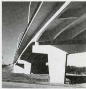
Ponts de l'autoroute Montréal-Laurentides
