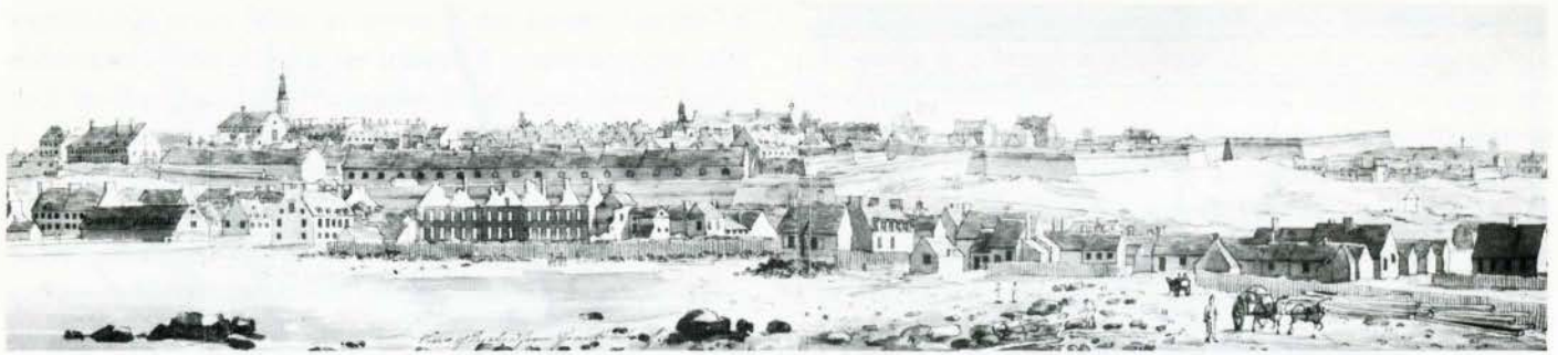
Figure 6. « View of Quebec from Grant's Wharf », dessin à l'encre et au lavis de George Heriot, vers 1790. (Archives nationales du Canada)
