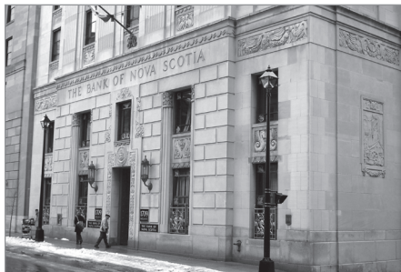
ILL. 14. SIÈGE SOCIAL DE LA BANQUE DE NOUVELLE-ÉCOSSE, HALIFAX, 1929-1930, JOHN M. LYLE, ARCHITECTE. | NICOLAS MIQUELON, PARCS CANADA, 2008.
