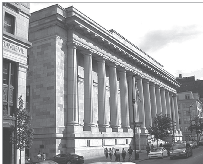
ILL. 25. ANCIENNE ANNEXE AU PALAIS DE JUSTICE DE MONTRÉAL, 1920-1926, AUJOURD'HUI L'ÉDIFICE ERNEST CORMIER, ERNEST CORMIER ET L.A. AMOS ET C.H. SAXE, ARCHITECTES. | flickr.com.
