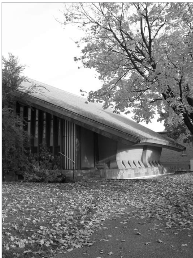
ILL. 2. ÉGLISE SAINT-RÉMI. VUE EXTÉRIEURE, BASSIN D'EAU ET MUR DU BAPTISTÈRE. | MARIE-DINA SALVIONE, 2008.
