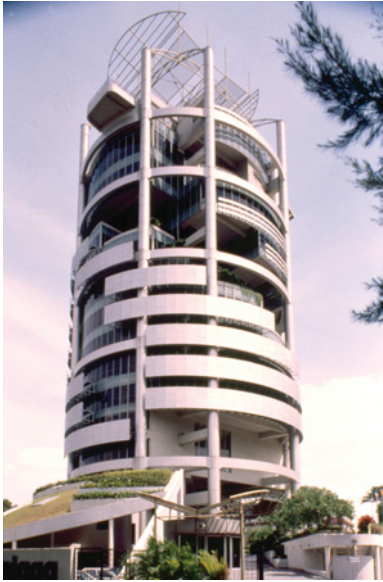
Menara Mesiniaga Photograph from MIT Library
