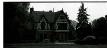
Ill. 34. La maison Harry Abbott (Birchfield) ; 240, chemin Senneville, Robert Findlay, architecte, 1892 et 1910, Edward Maxwell, architecte, 1899, élévation arrière. (CinéCité/Senneville, 1995)
