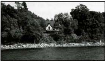
Ill. 7. Domaine Harry Abbott, vu du lac des Deux-Montagnes, montrant la résidence principale (Birchfield), Robert Findlay, architecte, 1892 et 1910, Edward Maxwell, architecte, 1899. (Pares Canada / Michel Pelletier, 2001)
