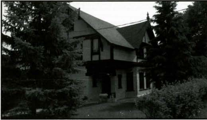
Ill. 30. Loge du gardien, domaine Angus ; 217-219 chemin Senneville, Edward Maxwell, architecte, 1895-1903. (CinéCité/Senneville, 1995)
