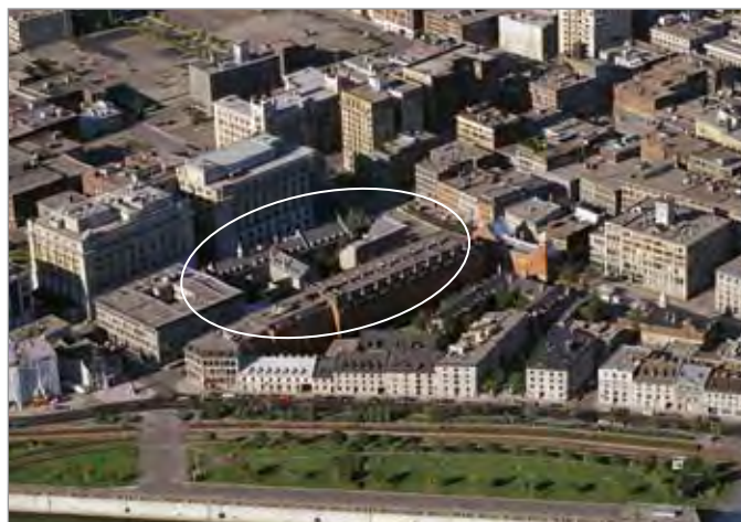
ILL. 6. MONTRÉAL. LE SITE DE L'ANCIEN HÔPITAL GÉNÉRAL DANS LE VIEUX-MONTRÉAL. | PIERRE LAHOUD.
