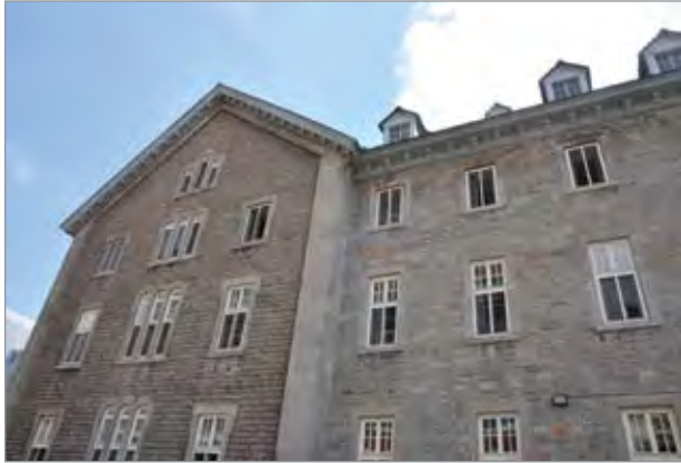
ILL. 48. MONTRÉAL. MAISON-MÈRE DES SŒURS GRIS. LA PIERRE À BOSSAGE DES FAÇADES ET LA PIERRE DE RANG PIQUÉE DES FAÇADES SECONDAIRES, SUR JARDIN. | GUILLAUME ST-JEAN.
